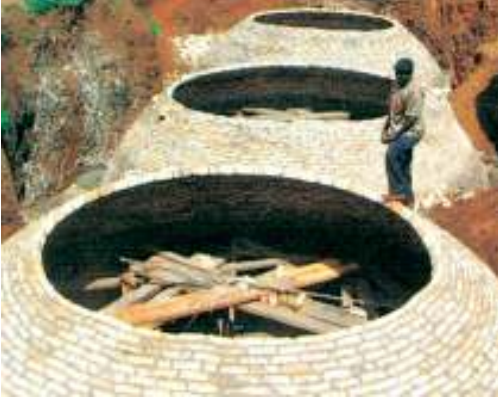
চিত্র 5.13 : জৈবগ্যাস প্ল্যান্ট (Biogas Plant)
